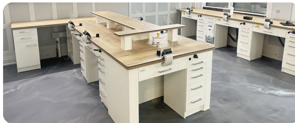
Umgesetzt – dasselbe Labor nach der Montage
